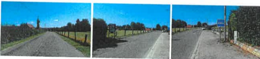
La RD70E3 est une voie primaire bénéficiant d'un trottoir sur le côté opposé à la zone et disposant d'un éclairage public L'accès potentiel depuis la RD70E3 - accès non aménagé, mais possible le long de la façade de projet L'arrêt de bus implanté en face de la zone
